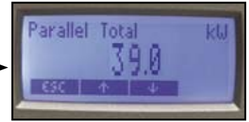
Выходные данные всей системы на экране любого из ИБП системы
