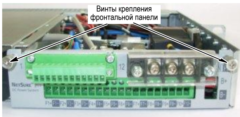
Рис 24. Демонтаж блока MFU (BMG 15226/1).
