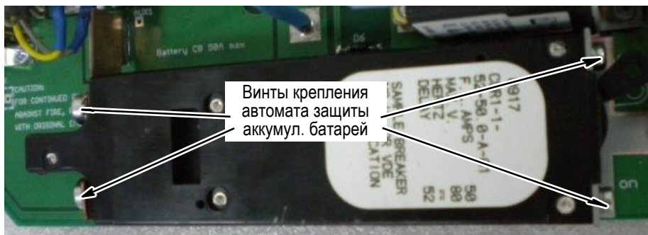
Рис 25. Замена автомата защиты аккумуляторных батарей.
