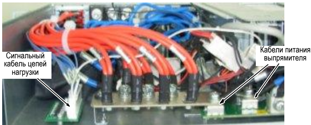
Рис 22. Демонтаж блока MFU.
