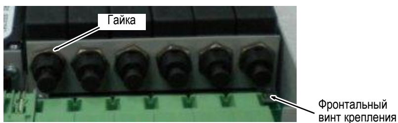
Рис 27. Замена распределительного автомата защиты.
