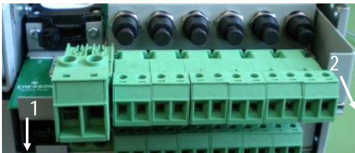
Рис 18. Демонтаж блока MFU.
