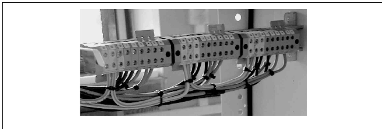
Рис. 16. Рис. 13. Выводы для подключения цепей переменного тока.
