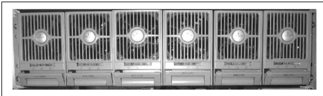
Рис. 8. Силовая полка выпрямителей с шестью выпрямительными блоками.
